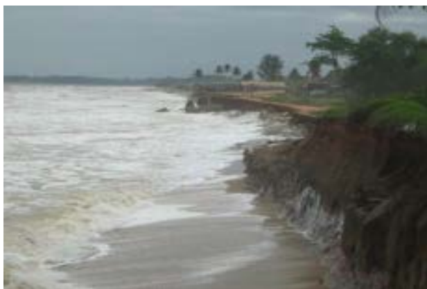
Figure 7: Érosion côtière à Grand-Lahou (source) PortBouet (source)
