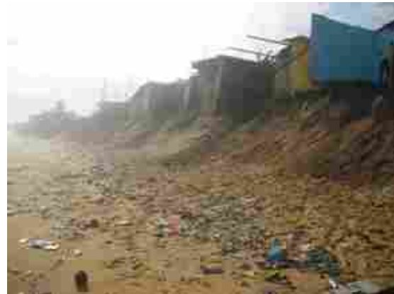
Figure 9 : Érosion côtière et destruction à Port-Bouet
